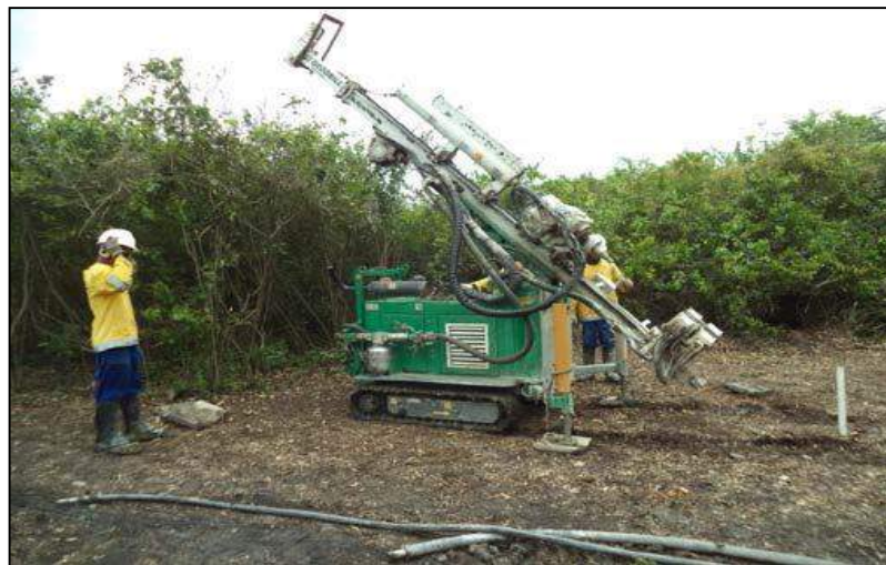
Foto 1 - Perfuratriz sendo posicionada para o início da sondagem.
