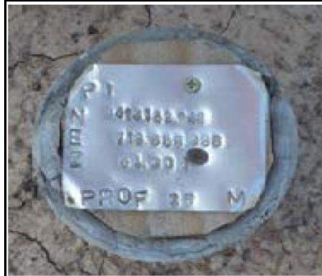
Figura 6 - Marco em concreto com placa metálica de identificação
